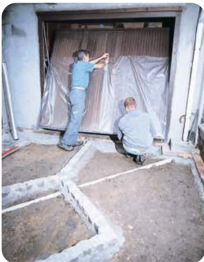
^ Mise en place du polyane de protection.
