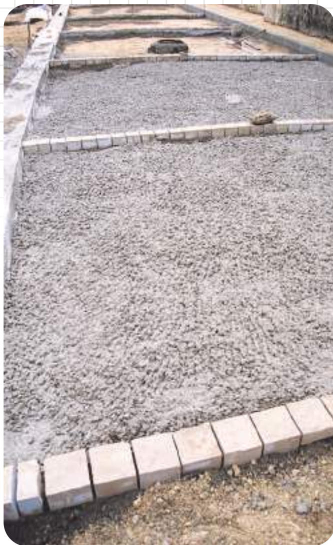
^ Un calepinage en briques ou en pavés peut avantageusement remplacer les joints.
